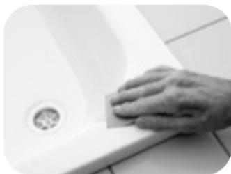
Die gespachtelte Stelle auf Keramik und Email mit braunem Schleifpapier sauber zuschleifen, so dass keine Überstände oder Löcher mehr zu sehen sind. Auf Acryl das beigefügte graue Nass-Schleifpapier mit Wasser angefeuchtet verwenden. Anschließend Schleifstaub entfernen und die Fläche reinigen.
