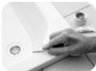
Die Schadstelle sauber ausspachteln, glätten und trocknen lassen. Bei Porzellan können abgebrochene Scherben mit der angemischten Spachtelmasse wieder angeklebt werden. Trockenzeit (temperaturabhängig):
